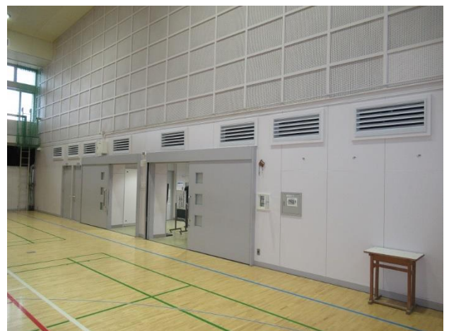
（空調機器設置工事を実施した昭和中学校体育館）
