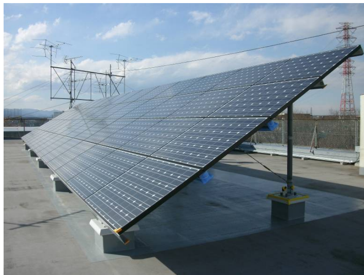
武蔵野小学校に設置された太陽光発電
