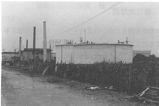
昭和43年 現在の入口付近から東に向かって撮影したもの。手前は第5、第6消化槽。
