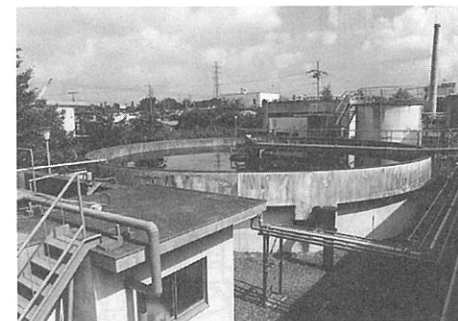
沈殿槽（平成2年休止）
