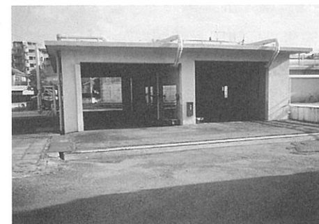
投入室（地下が投入槽）
