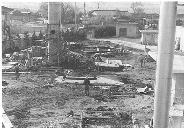
昭和45年 工事中の焼却炉
