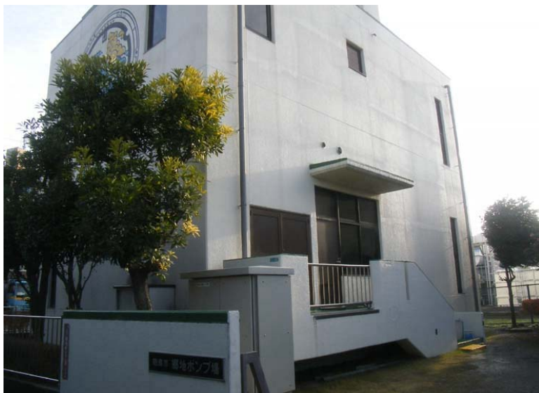
郷地ポンプ場
