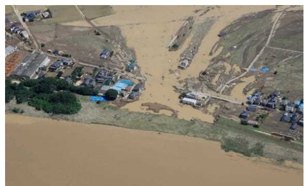
堤防決壊による家屋の流失(鬼怒川)
