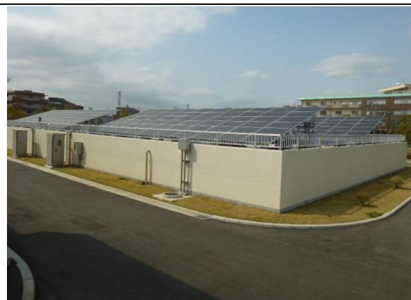
水道部（北部配水場）の太陽光発電システム
