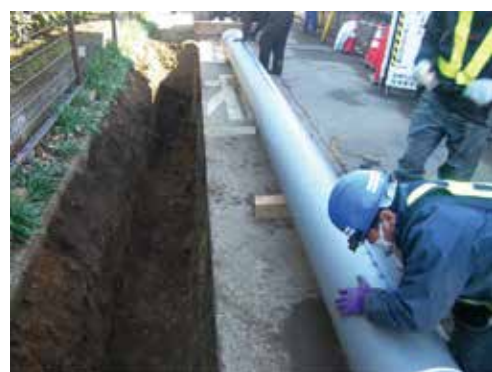
耐震管布設工事の様子
