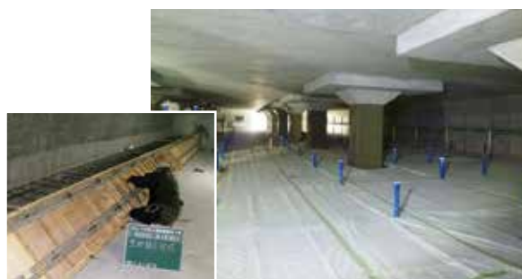
中央配水場耐震補強工事の様子
