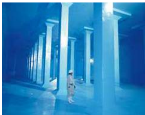
(配水池の中の様子)
