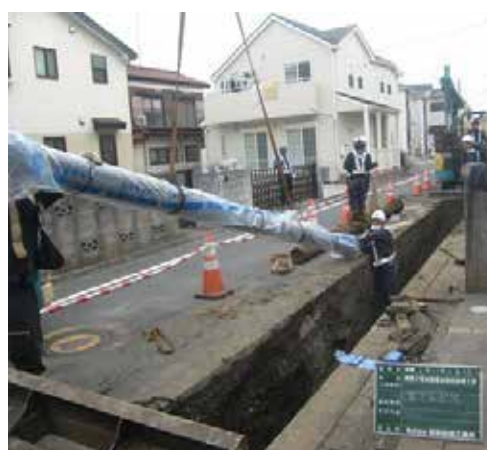
水道管布設工事の様子
