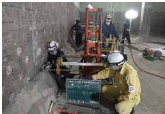
(配水池の耐震工事の様子)
