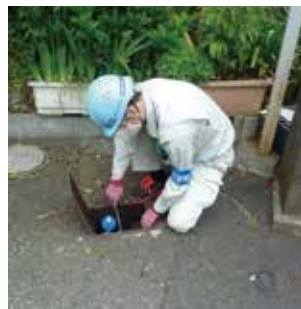
水道メーター取替えの様子
