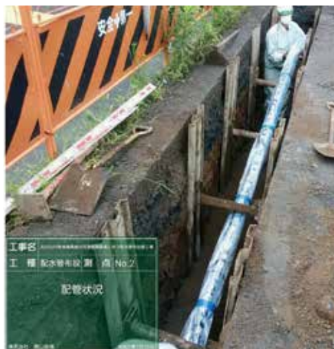
「水道配水用ポリエチレン管」の布設工事の様子
