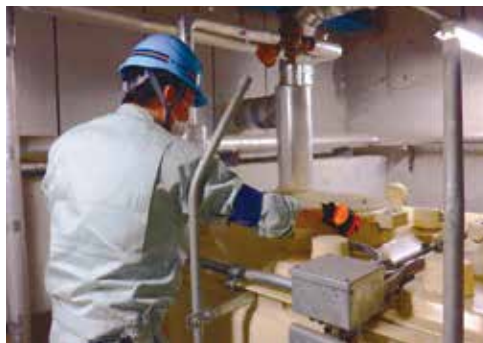
貯水槽水道調査の様子
