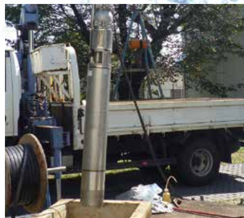
水源井のしゅんせつ工事の様子
