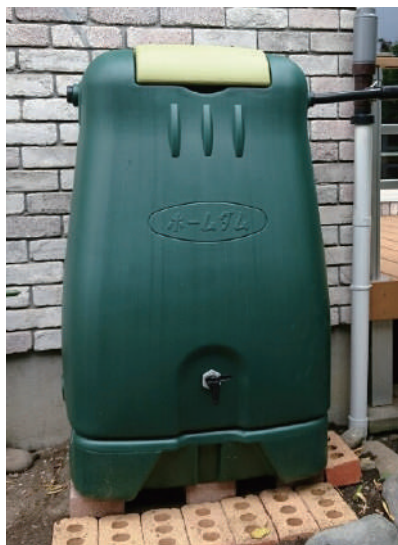
雨水貯留槽設置イメージ
