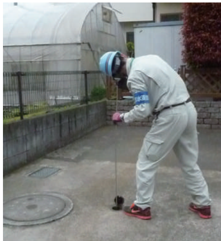
漏水調査の様子
