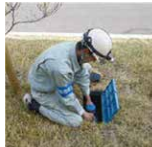
水道メーター取替え作業の様子
