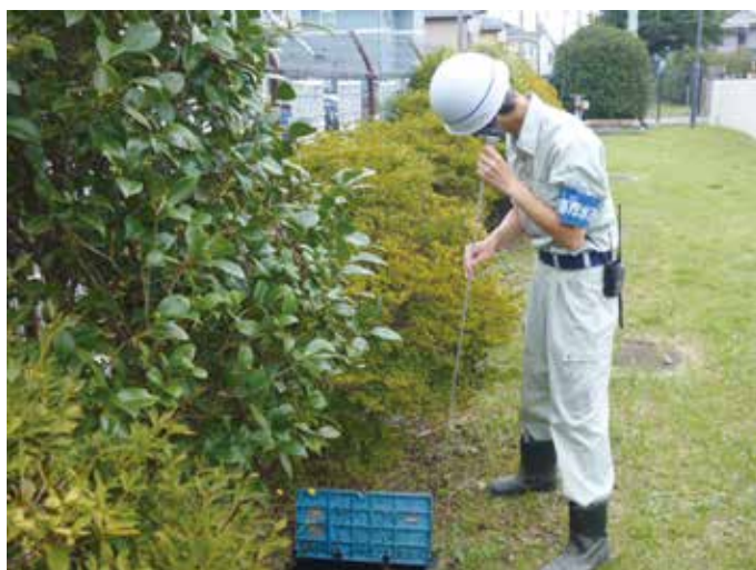
漏水調査の様子
