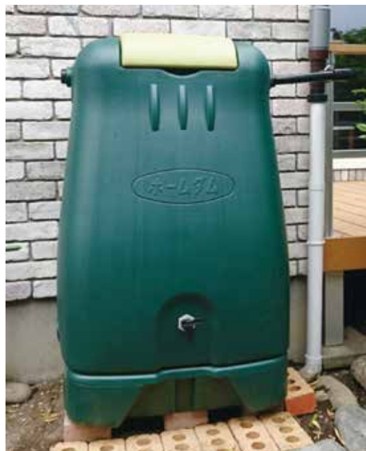
雨水貯留槽設置イメージ
