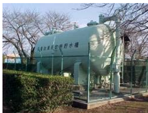
（写真：災害対策用飲料貯水槽）
