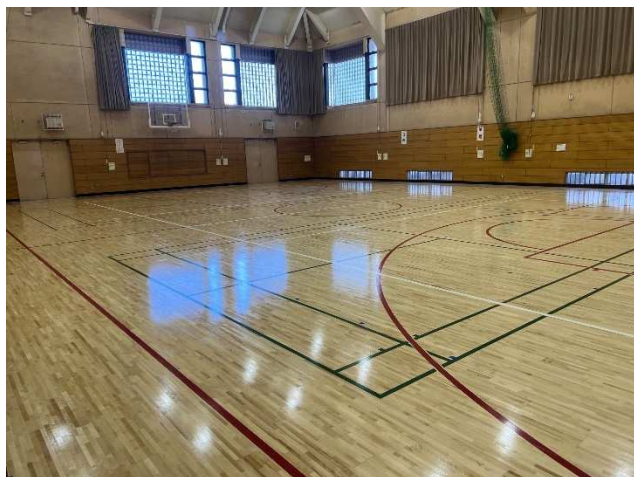
(みほり体育館床改修)
