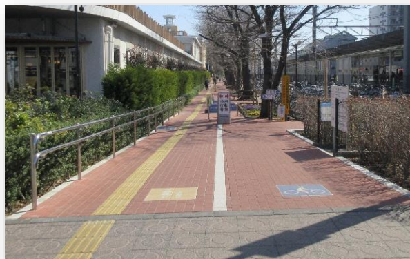
視覚障害者誘導用ブロック・手すりの設置
