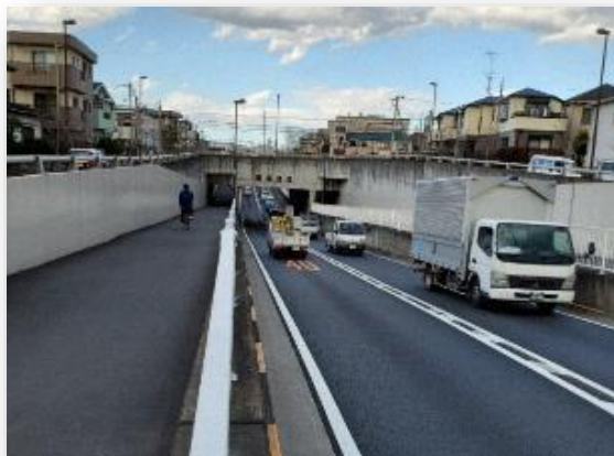
多摩大橋通りの立体交差
