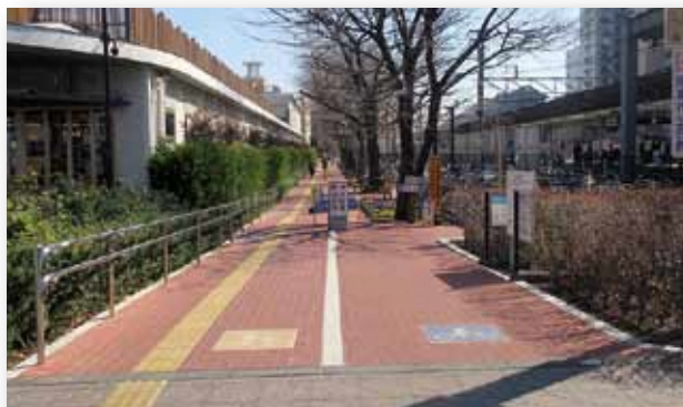
視覚障害者誘導用ブロック・手すりの設置
