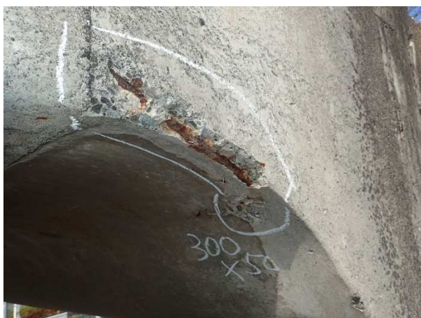
（主桁の剥離・鉄筋露出）
