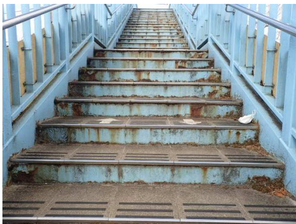
（階段部の腐食）
