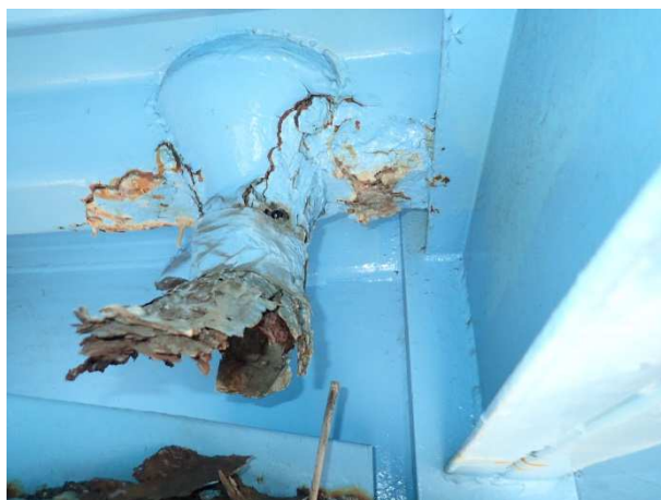
（排水管の腐食）
