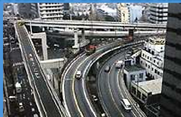
都市高速道路4号線（新宿出口付近）
