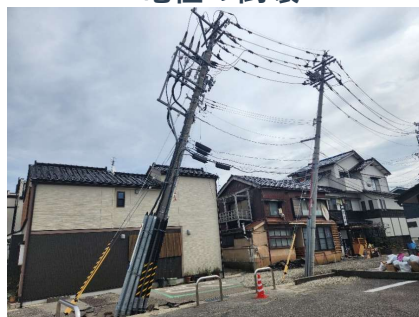
電柱の倒壊
