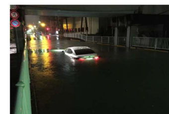
八高線アンダーパス（八王子市）
