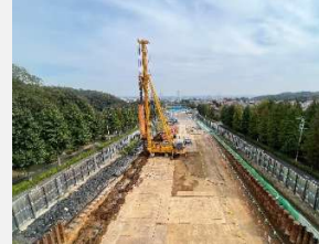
ICT建機による地盤改良工
