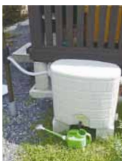
▲雨水貯留槽
