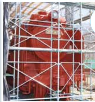
▲2回目のさび止め
