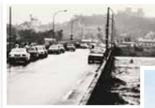
◀昭和49年頃の多摩大橋
