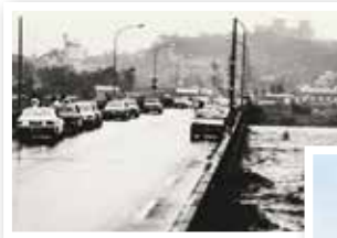
◀昭和49年頃の多摩大橋
