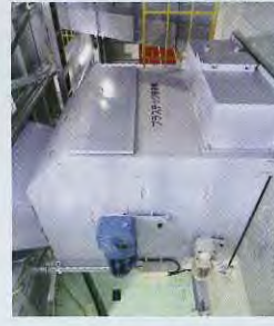
⑤プラスチック破袋機 回収された容器包装プラスチックを圧縮梱包します。
