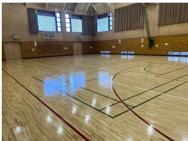
(みほり体育館床改修)
