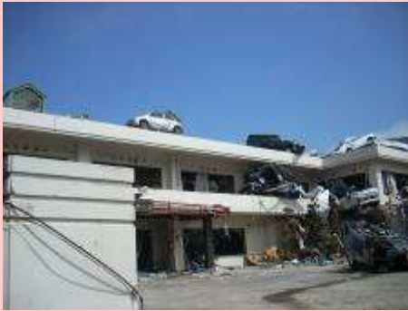
老人ホーム外観 屋根に車に乗っているのがわかる (山田町)
