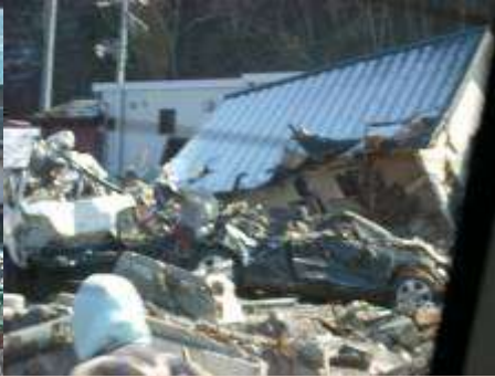
被災地住宅街 (小本地区)
