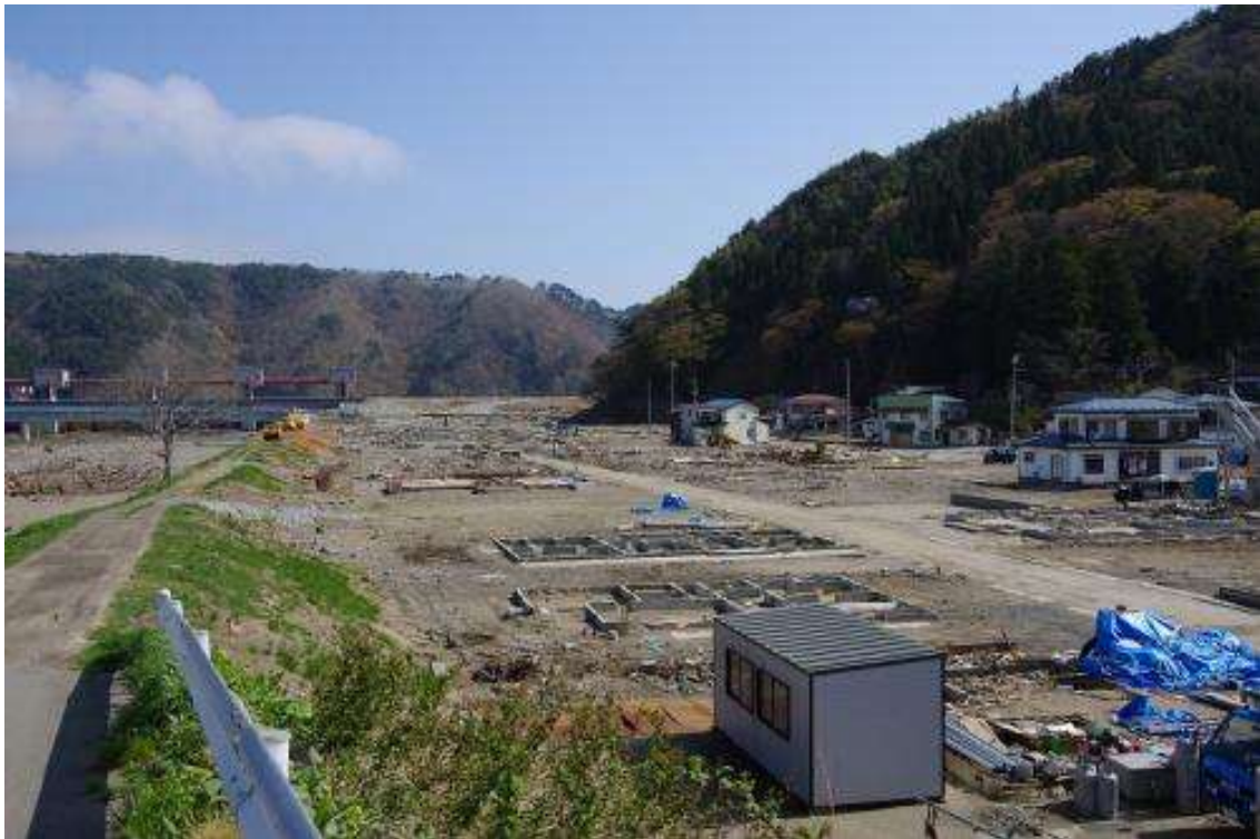
ガレキ撤去後の小本地区（5月6日）
