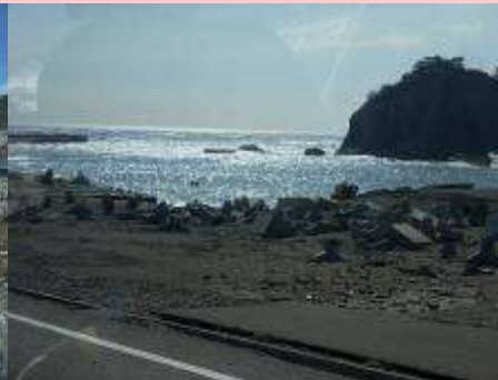
テトラポットが散乱している 中には割れているものもある (小本地区海岸)
