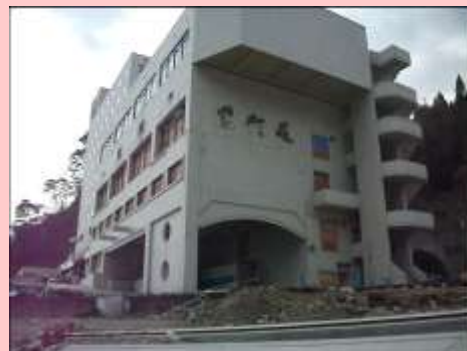
窓が割れた宿泊施設
