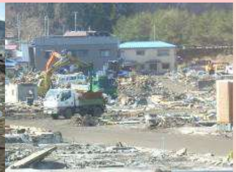
被災地住宅街 (小本地区)
