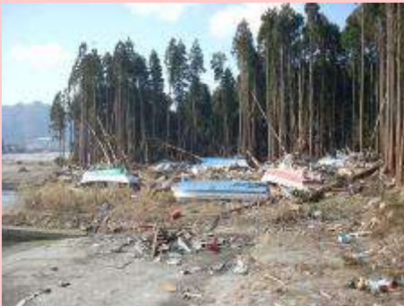
船が打ち上げられている (小本漁港)
