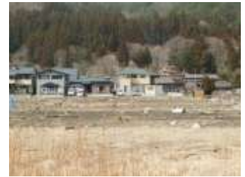
〈小本川水門から 2km 程離れた箇所〉
