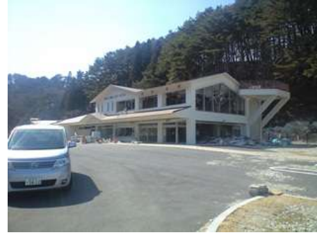
被災した浄土ヶ浜レストハウス
