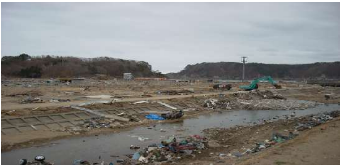
自衛隊による瓦礫撤去作業
