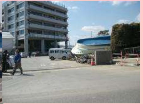
宮古市役所庁舎 庁舎玄関に船がさかさまになって流れ着いている
