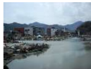
浸水している道路
