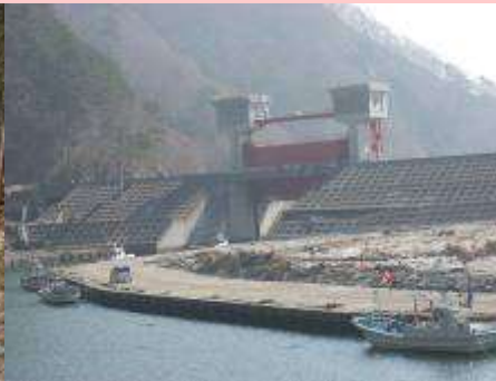
水門 震災時、門を閉めようとしたが、 停電のため閉まらなかったとの こと。
