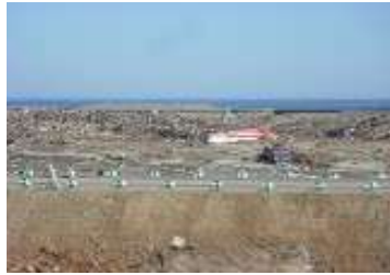
〈波にのまれた田老地区〉
