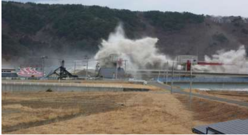
小本川水門に当たった津波（H23.3.11 写真提供：岩泉町）
