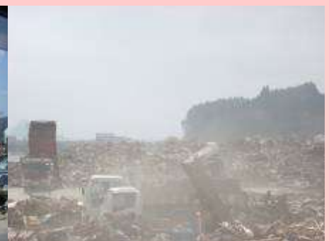
ガレキを運んでいるトラック 粉塵が舞っている (山田町)
