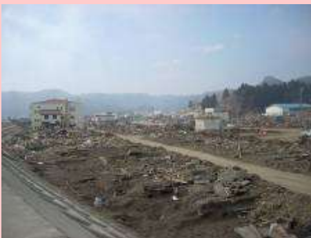
甚大な被害状況 (防潮堤から宮古方面を見た田老地区)
