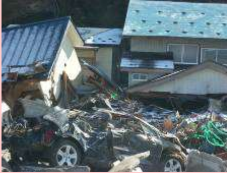
被災地住宅街 (小本地区)
