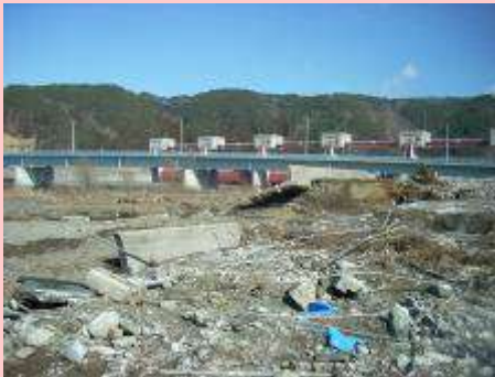
防波堤付近 (小本地区海岸)
