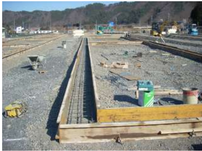
岩手アライ（株）隣接の小本仮設住宅（84戸）の基礎工事（H23.4.6）
