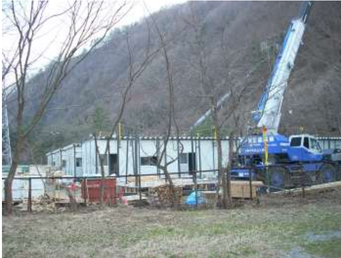
龍ちゃんドーム近くの岩泉団地（仮設住宅）39戸建設中（H23.4.13）
