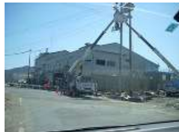
〈電力の復旧作業〉
