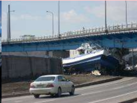
橋に船が突き刺さっている (宮古市役所付近)
