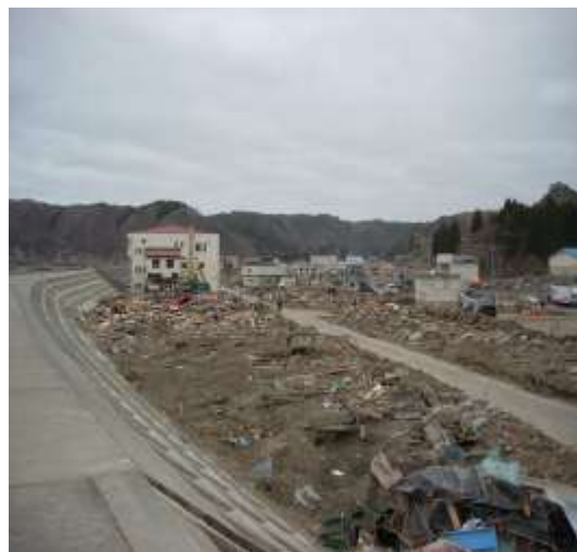
津波により住宅が破壊され、コンクリートの基礎のみが残っている、川には原型の残っていない車が多数見られた。（田老地区）
