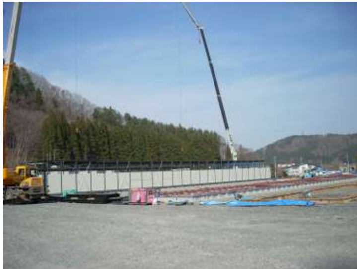
岩手アライ（株）隣接の小本団地（仮設住宅）84戸建設中（H23.4.13）
