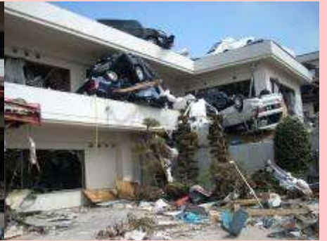
車が建物に突っ込んでいる (山田町)
