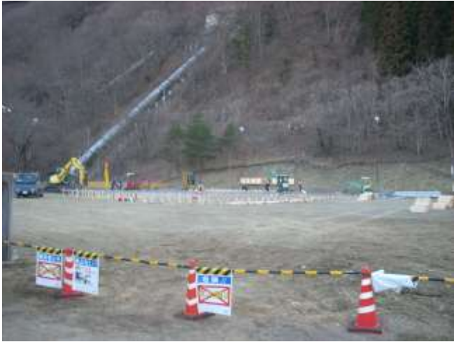
龍ちゃんドーム近くの岩泉仮設住宅（39戸）の基礎工事（H23.4.6）
