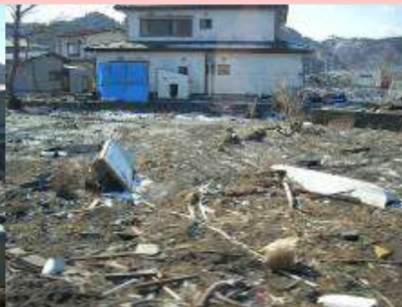
被災地住宅街 (小本地区)
