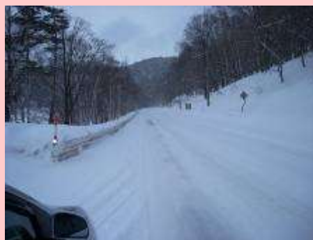
路面が雪で覆われている (早坂トンネル前)
