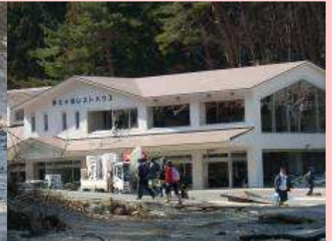
レストハウスのガラスはすべて割れている (浄土ヶ浜)
