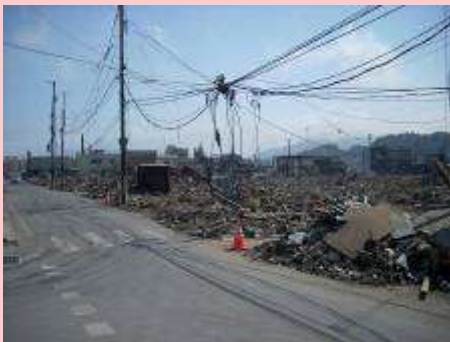
道路は通っているが、町は壊滅状態で電線がからまっている (山田町役場付近)
