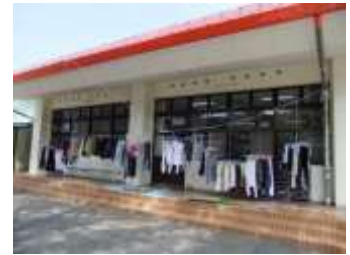
〈避難者用洗濯所〉
