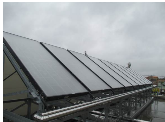
松原町コミュニティセンターの太陽光発電システム
