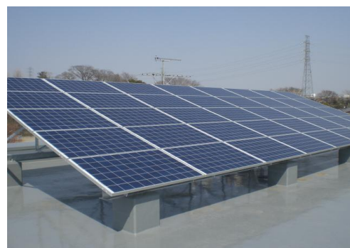
共成小学校の太陽光発電システム
