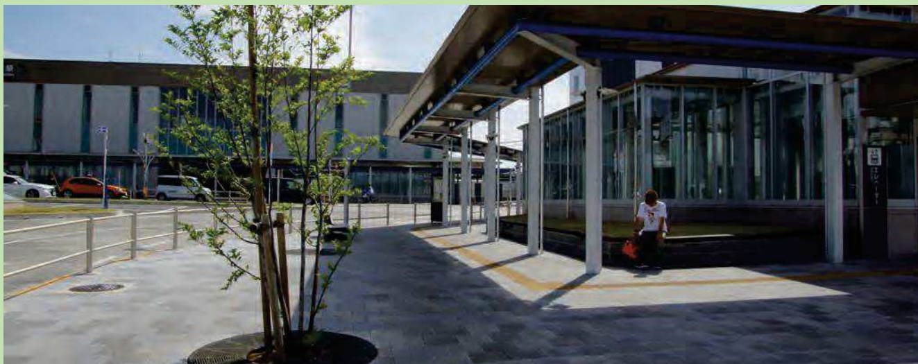
歩車分離が実施され駅前の空間も広々とした駅前広場
