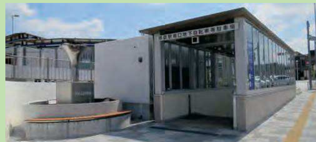
自転車等駐車場出入口
