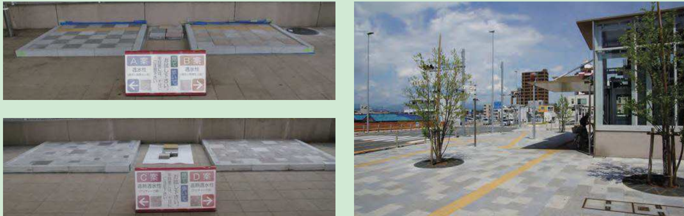
アンケートや試験施工を実施し歩道舗装デザインを決めました
