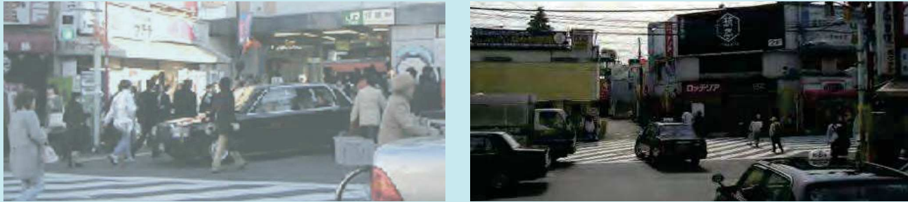
駅前の空間が狭く歩車分離も実施されていない駅前広場
