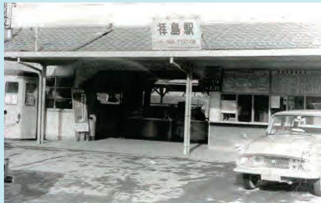
昭和 37 年頃の旧駅舎
