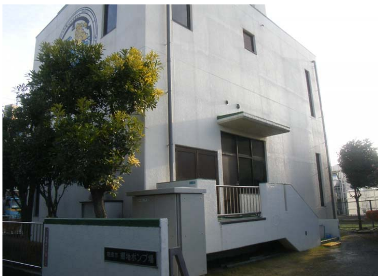
郷地ポンプ場
