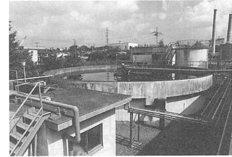
沈殿槽 (平成2年休止)
