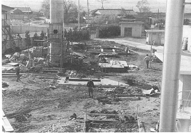
昭和45年 工事中の焼却炉
