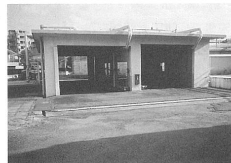
投入室（地下が投入槽）
