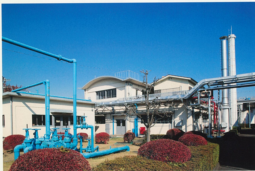
中央の建物は1階がボイラー室、2階左側が会議室、右側は宿直室
