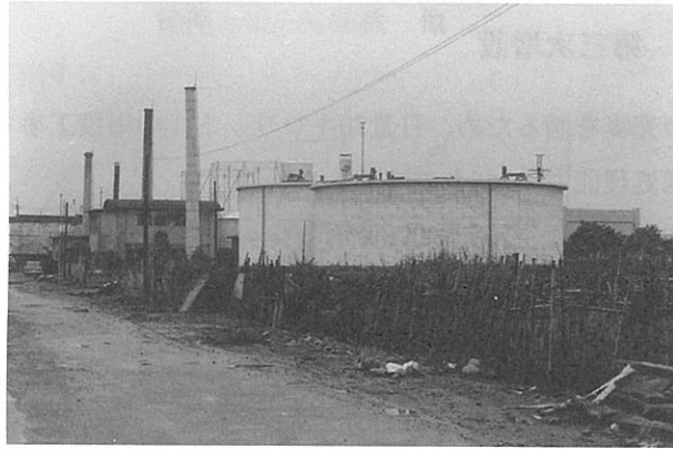
昭和43年 現在の入口付近から東に向かって撮影したものの。手前は第5、第6消化槽。
