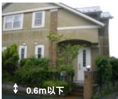
0.6m以下のブロック塀を設け、その上に柵を設けている。
