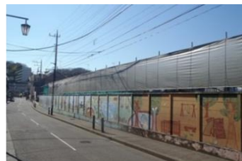
防薬シャッターの整備
