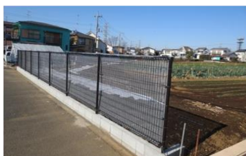
土留め、フェンスの設置
