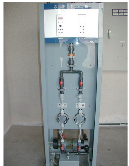
次亜塩素酸注入機
