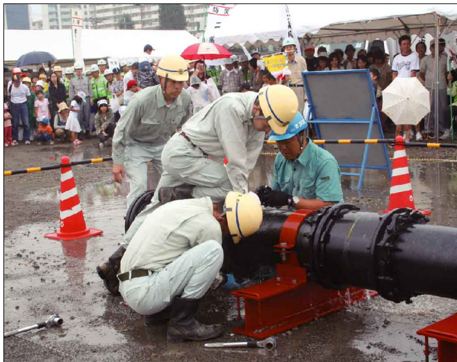
（破損配水管の応急復旧訓練）
