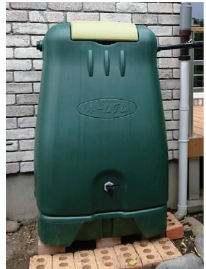
雨水貯留槽設置イメージ
