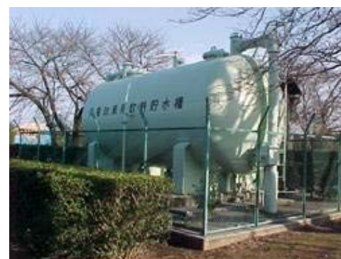
(写真：災害対策用飲料貯水槽)
