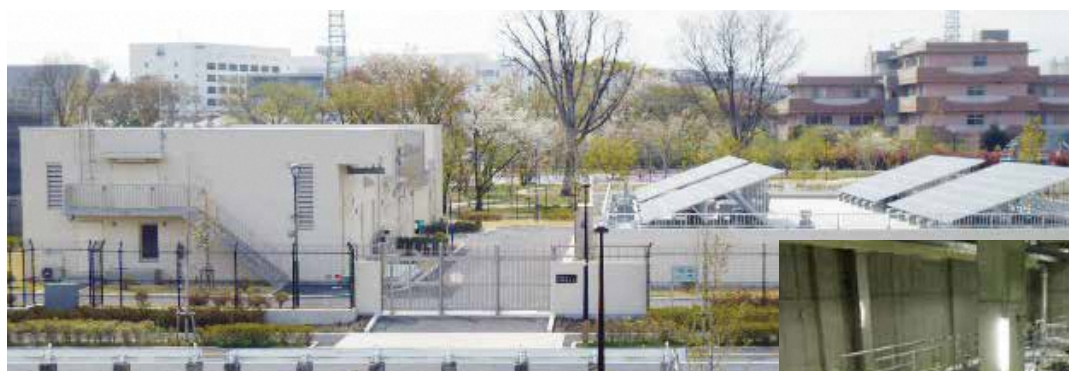
上は平成 29 年 6 月に竣工した北部配水場 左側の建物がポンプ棟 右側の太陽光発電用パネルがあるのが配水池 右下はポンプ棟のポンプ室
