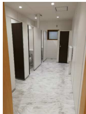
▼改修後のトイレ(やまのかみ会館)
