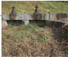
九ヶ村用水取水口跡
